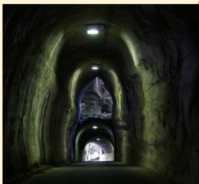
二階建てトンネル (共栄向山トンネル)
