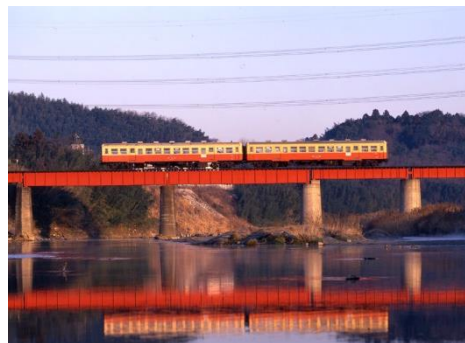
橋梁の上をはしる小湊鐵道
